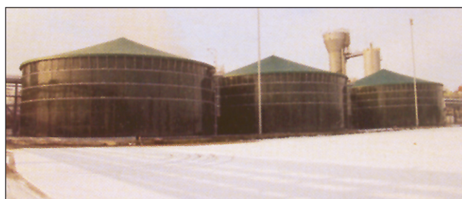
شکل ۸a: راکتور بدون هوازی در کارخانه KWL سه مخزن و...
