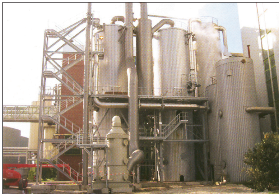
شکل ۶: اولین قسمت تصفیه شربت در کلون اولین قسمت کربناتاسیون دوم تشکیل شده از آهک‌خور اصلی سرد و واکنش بعدی کربناتاسیون دوم
