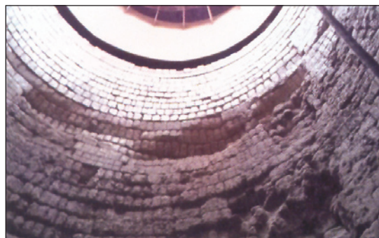
شکل ۹: آسیب‌دیدگی کوره آهک در کارخانه Schladen
