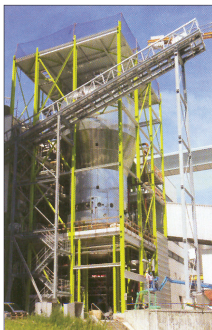
شکل ۷: خشک کن بخاری ۲ در Uelzen، انتقال یافته از کارخانه متوقف شده Güstrow
